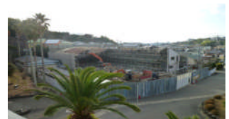
旧体育館が解体されました
