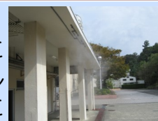
ホームルーム棟入口
