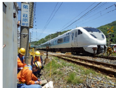
紀伊内原由良外通信ケーブル取替 第一萩原踏切 特急車両
