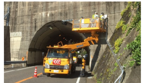
高濱トンネル 高所作業車両
